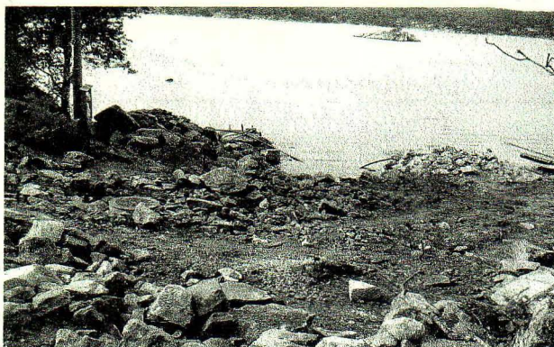
Fra Bergstøbrygga. Her er vannledningen lagt ut over fjorden og grøften er gjennggravd.
