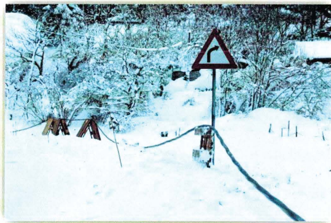
Kabelen ble lagt på bukker og hengt på skilt langs veien.
