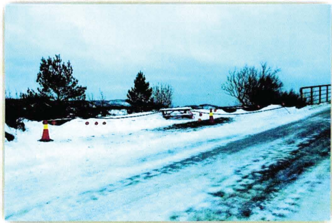
Her er kablen før den går videre over broen.
